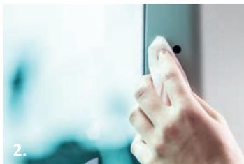
**2.** Markierte Klebeflächen mit 3M™-Tuch gründlich reinigen und gut ablüften lassen. Als Klebeflächen für Metallpads eignen sich Kunststoff- oder nichtmagnetische Metallflächen (z. B. Aluminium) sowie Fensterglas. Nicht geeignet sind textile oder gummierte Flächen (z.B. Fensterdichtung).
